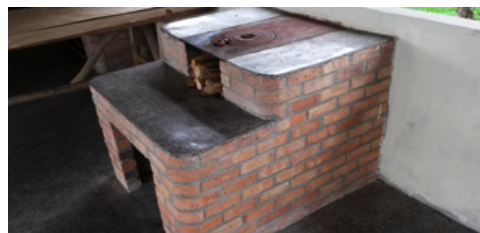
Fogão de lenha de consumo eficiente
